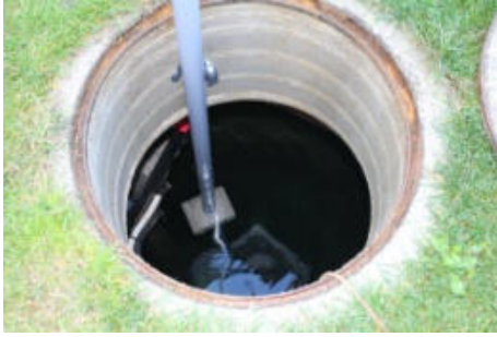
9. Rohr vorsichtig auf den Grund der vollen Zisterne ablassen
